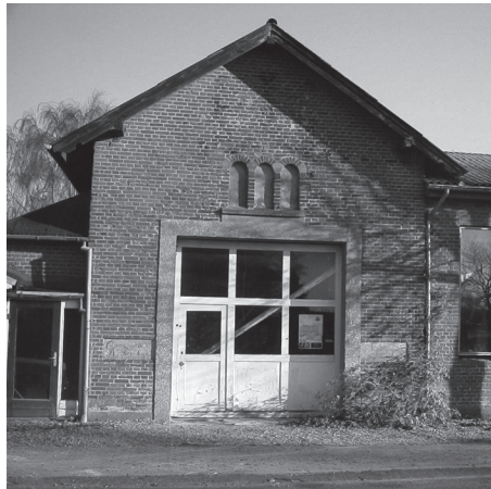
Det gamle elværk
